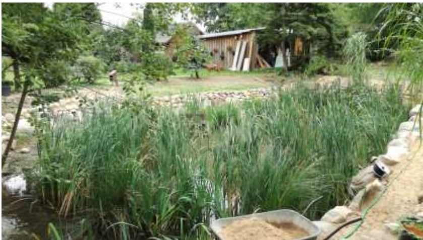
Foto 3: Regenrückhaltebecken, naturnah gestaltet mit Rohrkolben, Seggen, Stauden
